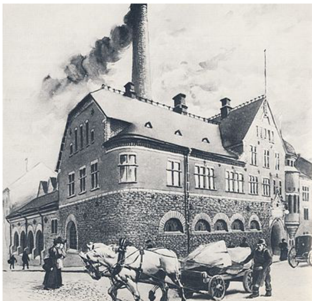
Ovan Brunckerbergverket. Strömmen kom från jättelika akumulatorbatterier, som laddades av en dynamomaskin, som i sin tur drevs av tre ångmaskiner på sammanlagt 4000 hästkrafter.
